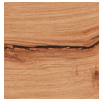
Akzent Risseiche Massivholz mit Querriss
